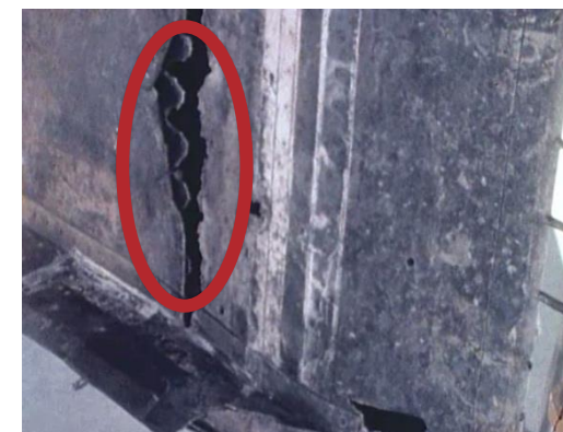
Pylon Rip due to SBLI
